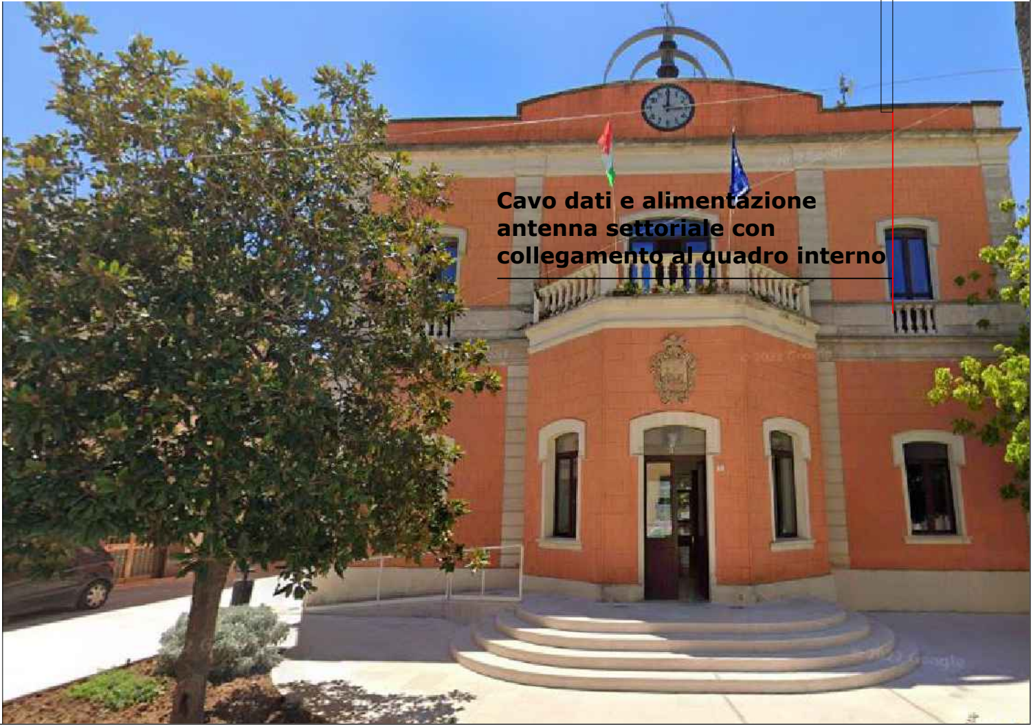
SCHEMA POSTAZIONE ANTENNA SETTORIALE
